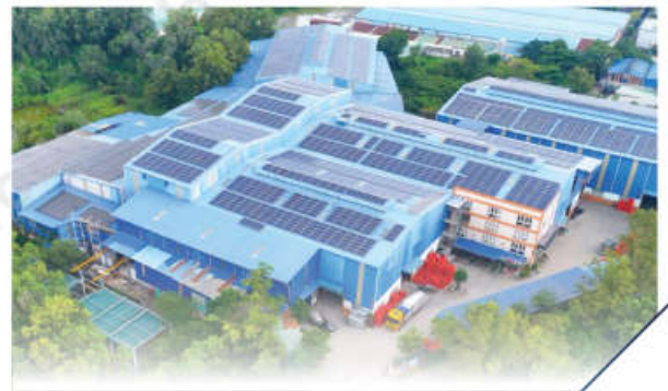
Nhà Máy BHT Hóa An BHT Hoa An Factory
