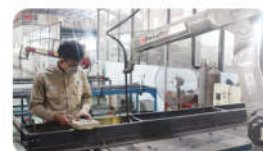
Quy trình hàn Welding process
