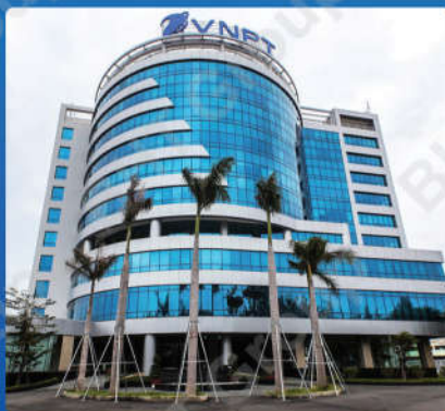
TRUNG TÂM DỮ LIỆU VNPT IDC VNPT IDC Data Center
