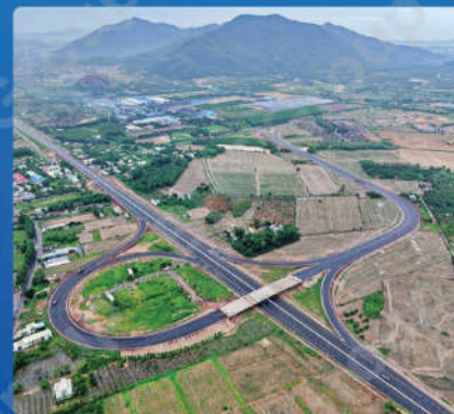
CAO TỐC BIÊN HÒA - VŨNG TÀU Bien Hoa - Vung Tau Expressway
