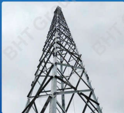
D/A NÂNG CẤP HẠ TẦNG TẠI THANH HÓA Infrastructure Upgrade Project - Thanh Hoa
