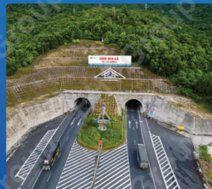
HẦM ĐƯỜNG BỘ QUA ĐÈO CẢ - PHÚ YÊN Deo Ca Road Tunnel - Phu Yen
