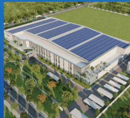
NHÀ MÁY MAKIO HUNG YÊN Makio Hung Yen Factory
