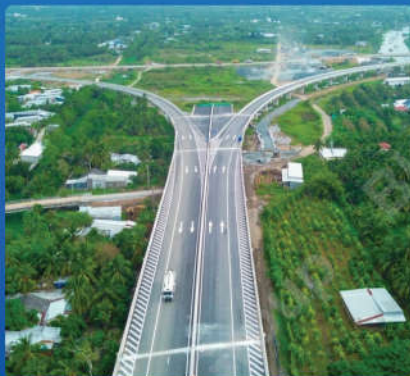
CT CẦN THƠ - HẬU GIANG - CÀ MAU Can Tho - Hau Giang - Ca Mau Expressway
