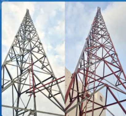
D/A TRỤ VIỄN THÔNG TẠI TỈNH CÀ MAU Telecom Tower Project in Ca Mau Province
