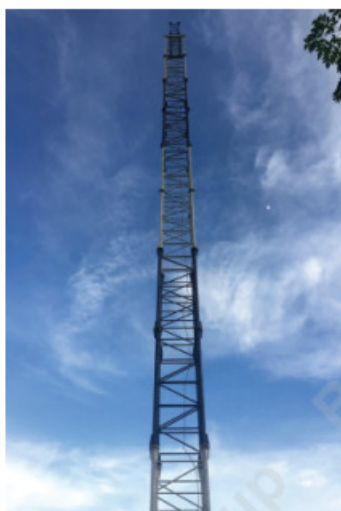
Trụ tự đứng tứ giác Square self-supporting tower
