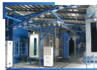
Sơn tĩnh điện Automatic powder coating
