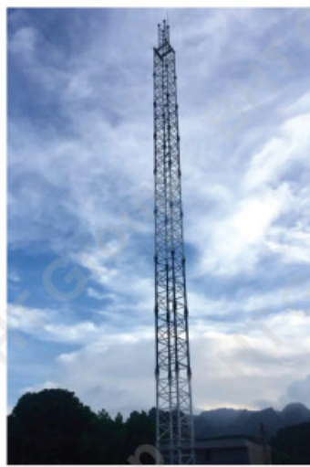
Trụ tự đứng tứ giác Square self-supporting tower
