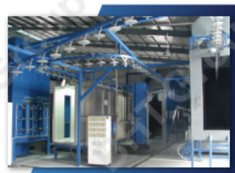
Sơn tĩnh điện Automatic powder coating
