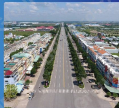
Khu Công Nghiệp Bàu Bàng - Bình Dương Bau Bang Industrial Park - Binh Duong
