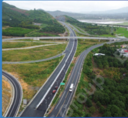
Cao Tốc Nha Trang - Vân Phong - Chí Thạnh Expressway Nha Trang - Van Phong - Chi Thanh
