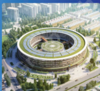
FPT Complex - FPT City Đà Nẵng FPT Complex - FPT City Da Nang
