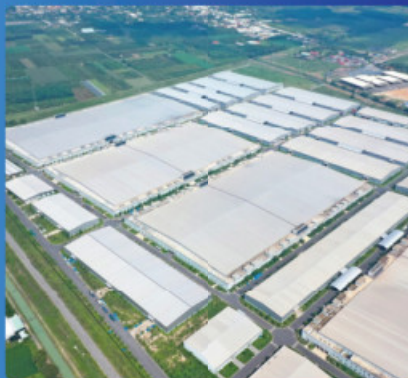
Nhà máy Brotex - KCN Phước Đông Brotex Factory - Phuoc Dong Industrial Park
