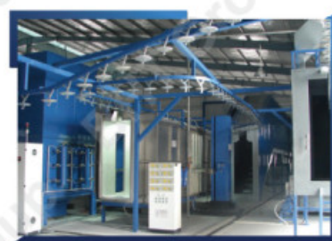
Sơn tĩnh điện Automatic powder coating
