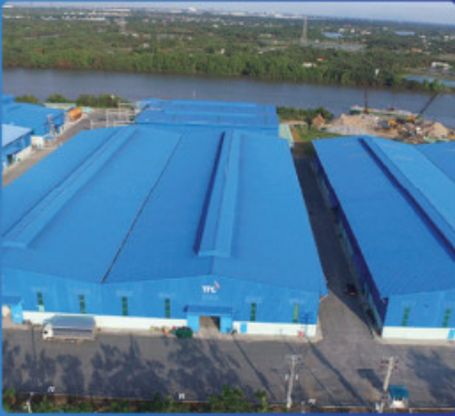
Tổng kho Đặng Huỳnh Dang Huynh Warehouse
